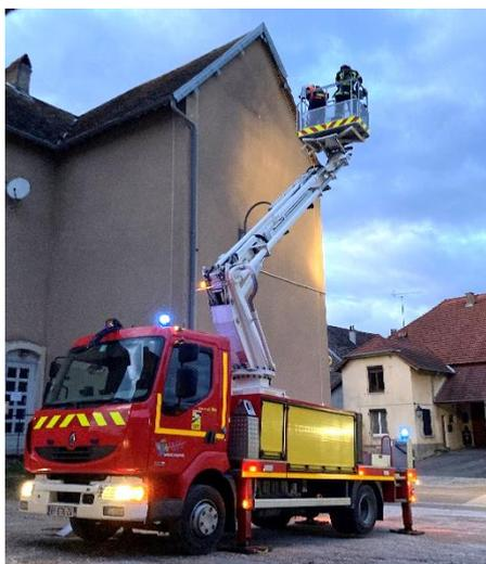
Dimanche 26 février, des bourrasques de vents sont annoncées par Météo France : c'est ainsi qu'un morceau de la rive du toit du bâtiment communal abritant les infirmières et l'APC s'est décroché. Long d'environ 1,70 mètres et pesant plusieurs dizaines de kilos, ce morceau de tôle branlait dans le vide, n'était tenu que par un clou et menaçait de tomber à tout moment.
