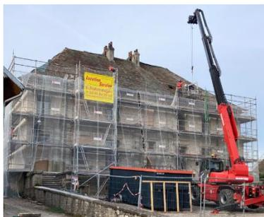
Moins de deux semaines ont été nécessaires pour que l'échafaudage soit installé. Les équipes de charpente commencent à détuiler et les maçons commencent à piquer l'enduit.
