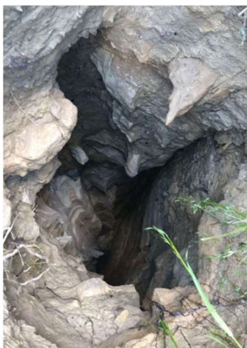
Gouffre de 14 mètres sur le talus droit de la RD 3
